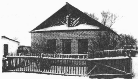
Рис. 2. Саманная изба, обложенная кирпичом. д. Таш-Куспяново Большнгушицкого р-на. 1998 г.
