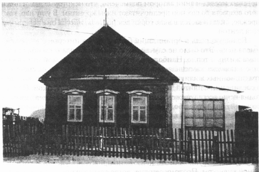
Рис. 3. Деревянная изба в д. Кочкиновка Большечерниговского р-на. 1998 г.
